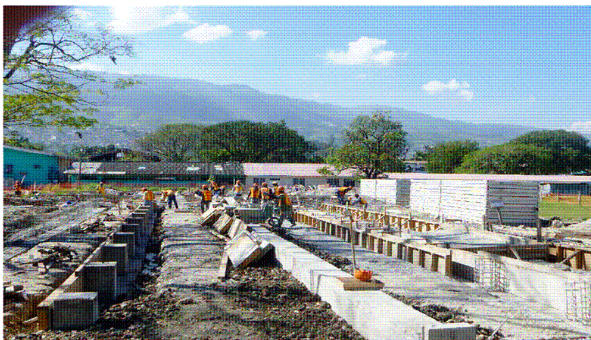
Travaux de fondation
